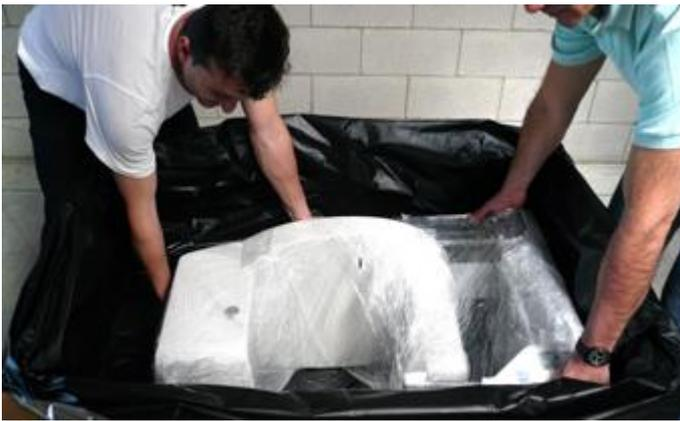
**i** NOTA. No retirar la película del brazo rotatorio hasta el final del montaje mecánico, cuando la unidad esté asegurada a la pared o al suelo.
